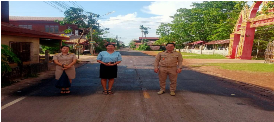
รูปภาพขณะดำเนินการก่อสร้าง จุดที่๑
