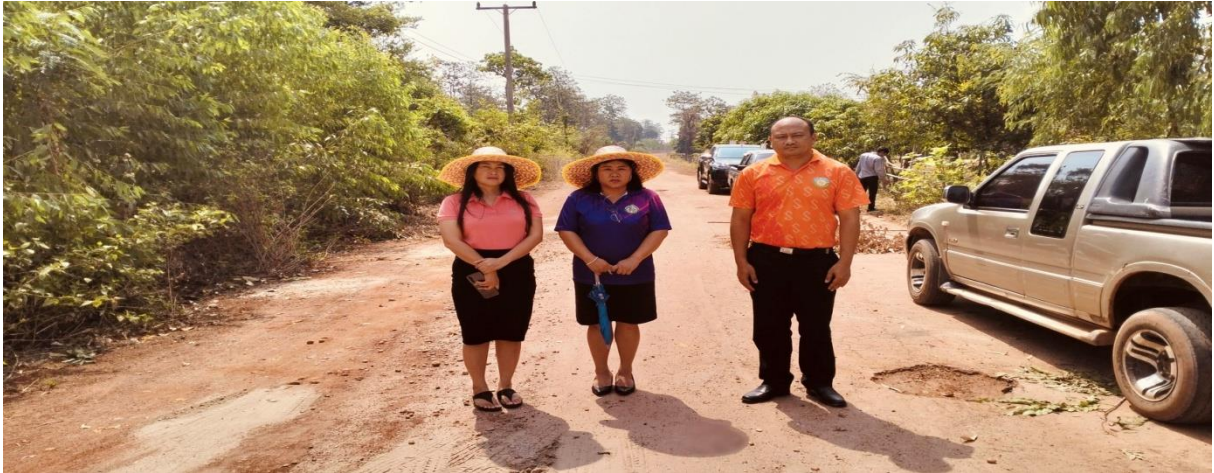
รูปภาพกำลังดำเนินการก่อสร้าง
