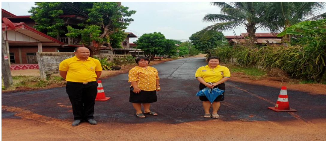
รูปภาพขณะดำเนินการก่อสร้าง จุดที่ ๒
