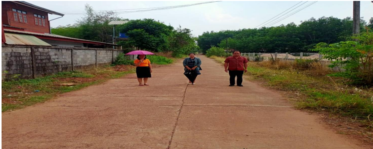
รูปภาพขณะดำเนินการก่อสร้าง
