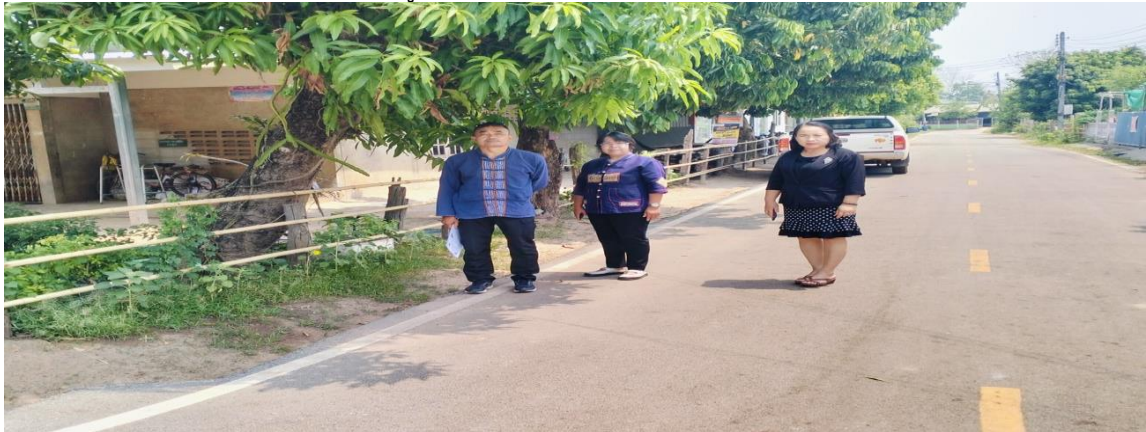
รูปภาพกำลังดำเนินการก่อสร้าง
