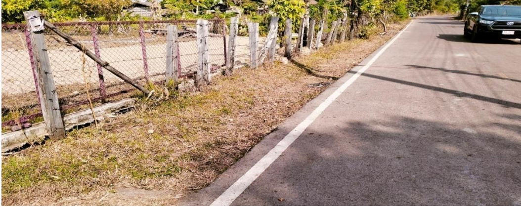
รูปภาพกำลังดำเนินการก่อสร้าง
