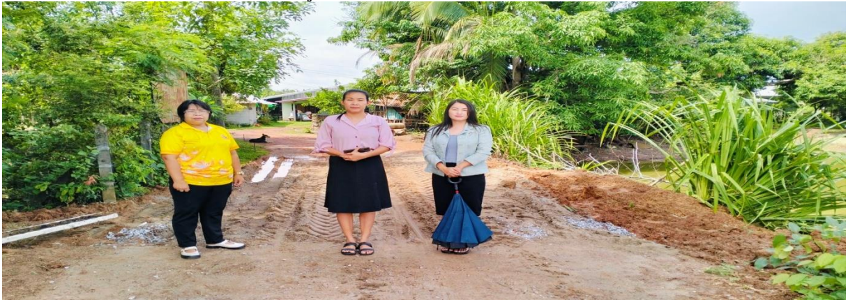
รูปภาพกำลังดำเนินการก่อสร้าง
