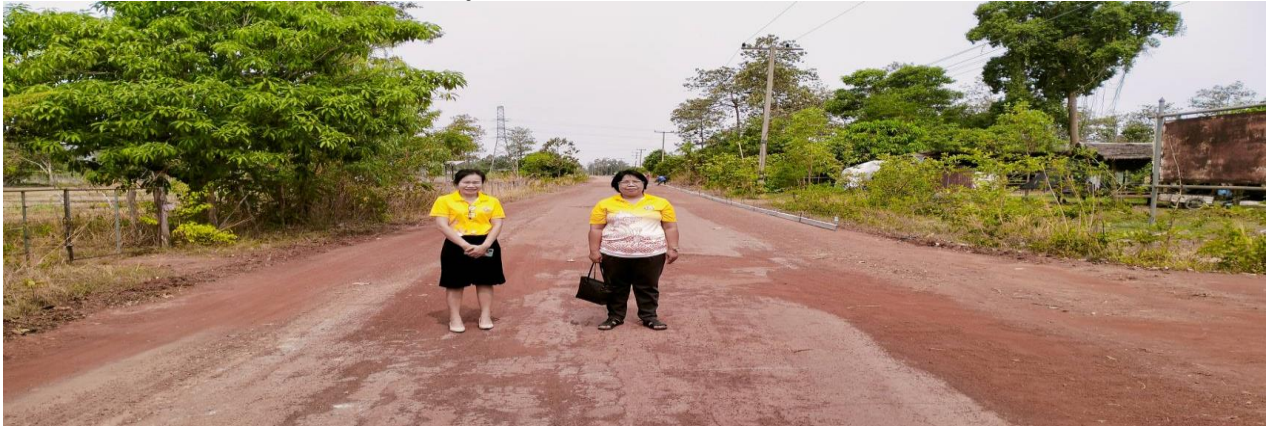
รูปภาพกำลังดำเนินการก่อสร้าง
