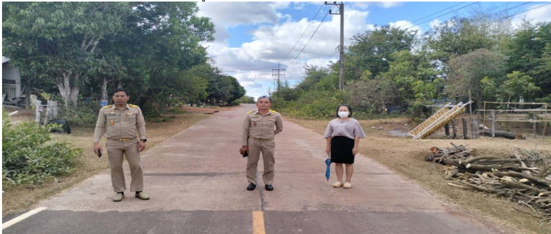
รูปภาพกำลังดำเนินการก่อสร้าง
