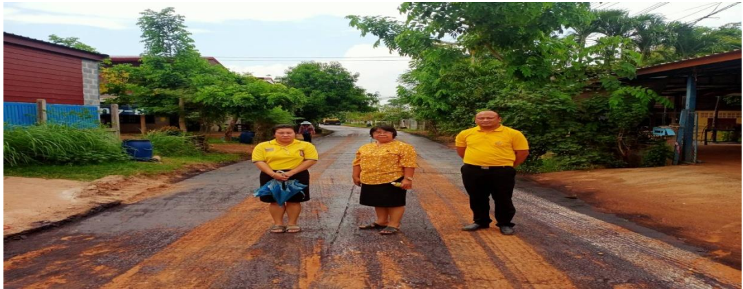
รูปภาพขณะดำเนินการก่อสร้าง จุดที่ ๑
