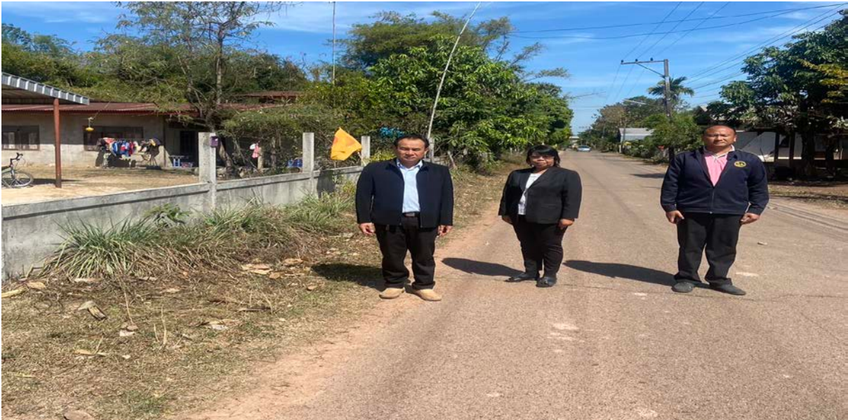
รูปภาพระหว่างดำเนินการก่อสร้าง จุดที่ ๒
