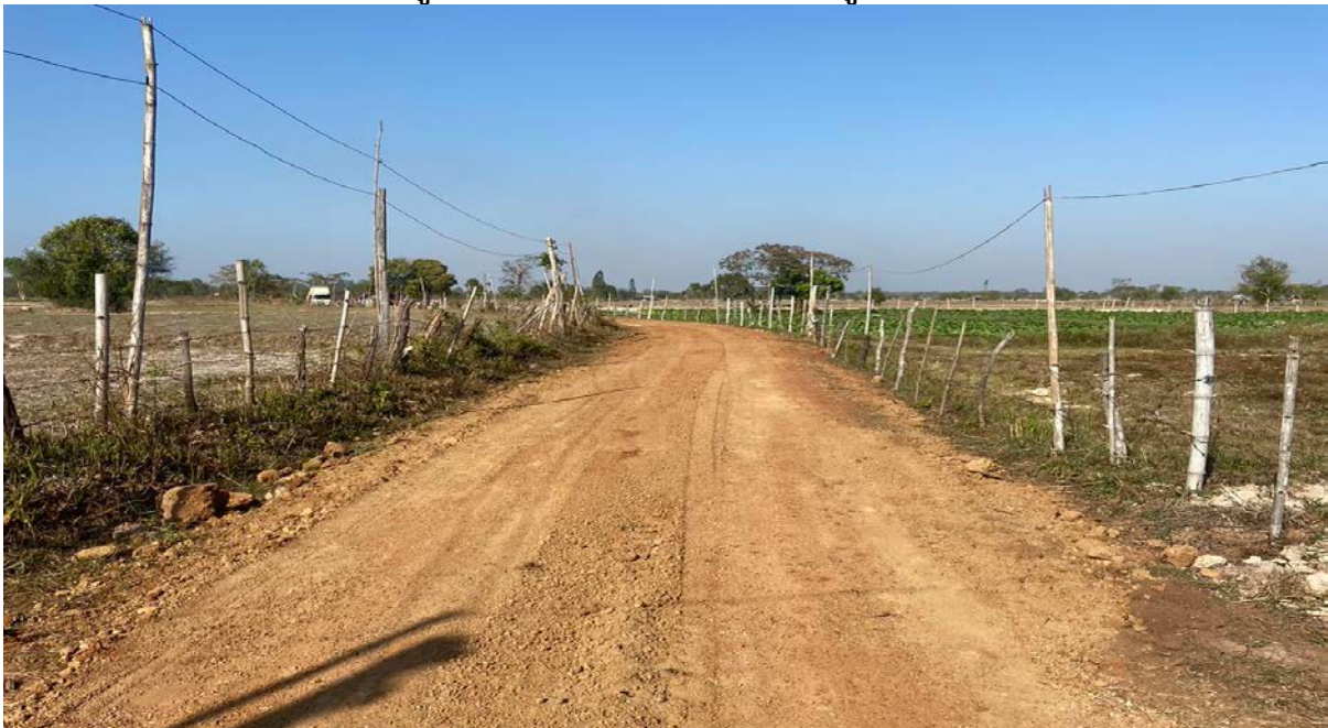
รูปภาพดำเนินการแล้วเสร็จ หมู่ที่ ๔
