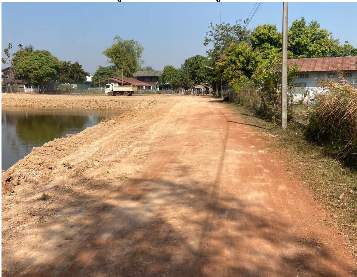
รูปภาพกำลังดำเนินการ หมู่ที่ ๑๐
