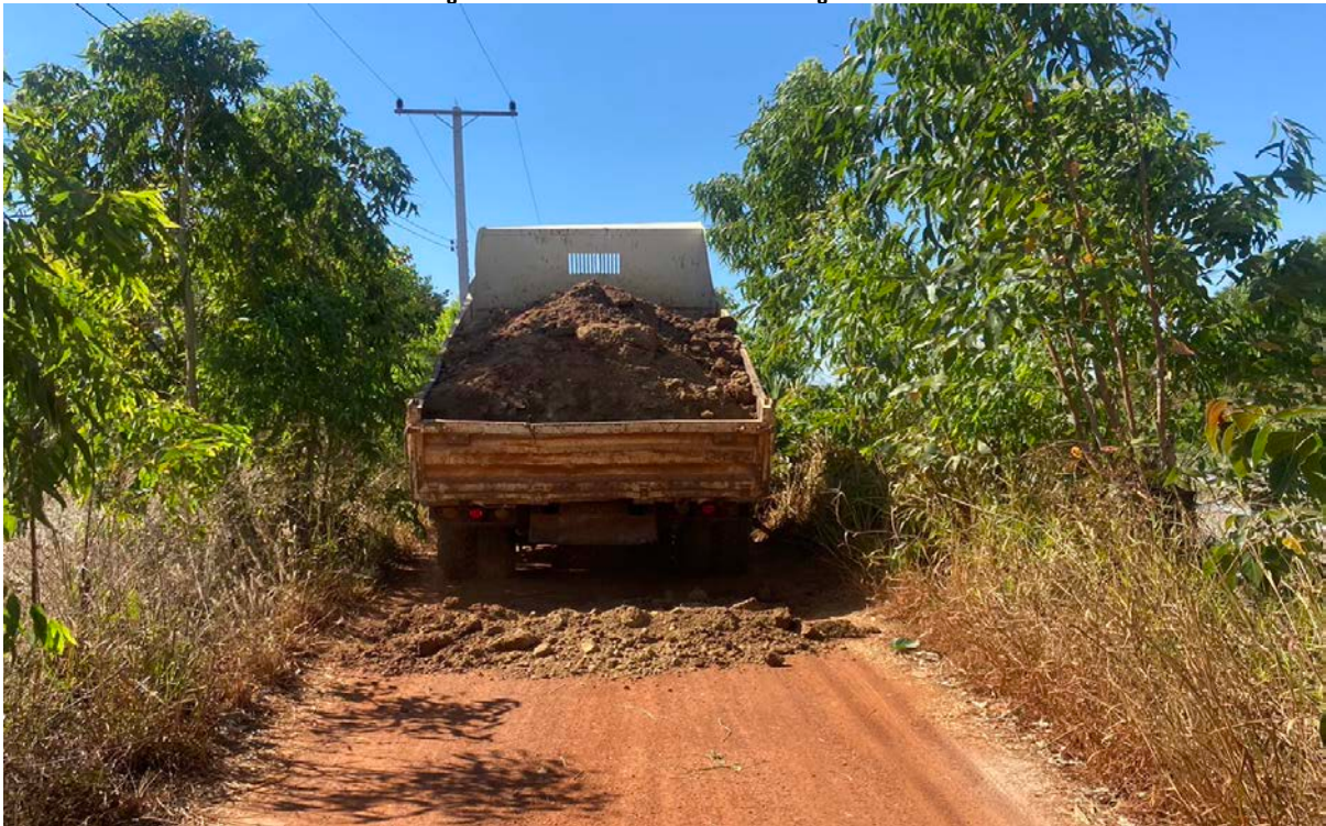
รูปภาพกำลังดำเนินการ หมู่ที่ ๕
